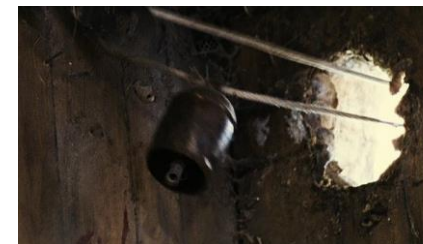
Incendie dans la cuisine - 4 -
